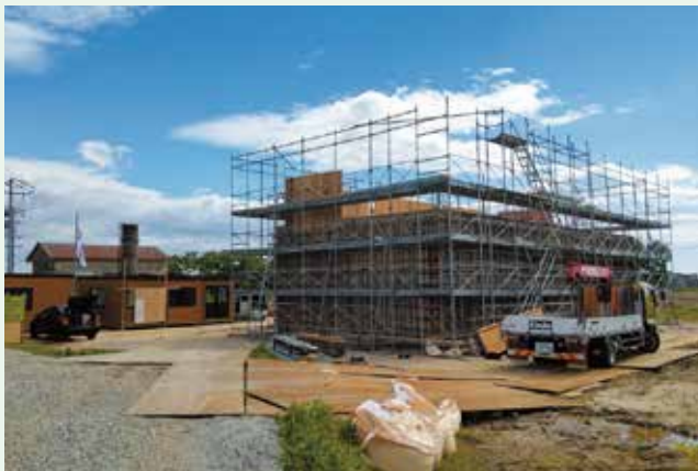
揚水機場建築状況
