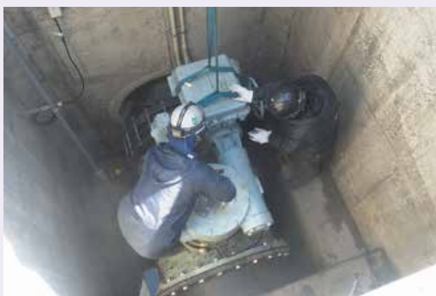
電動制水弁据付状況
