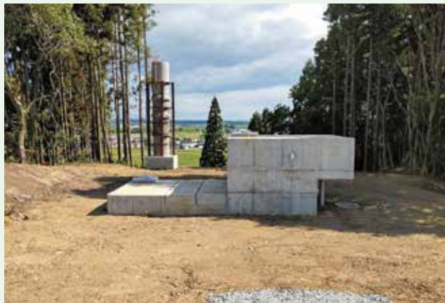
サージタンク（調圧水槽）完成
