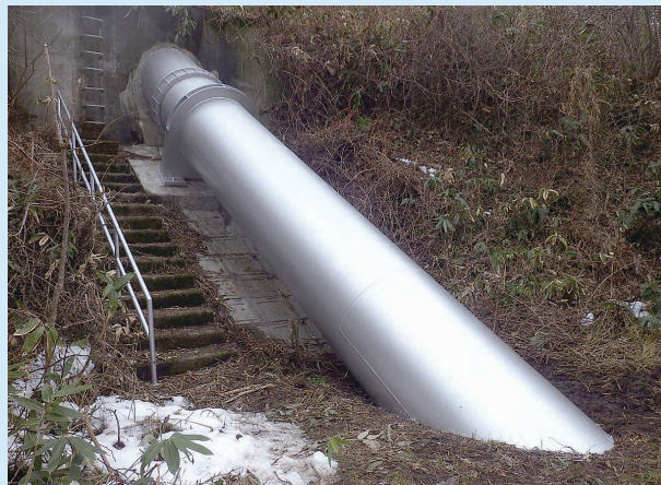
浅内支線用水路露出管
