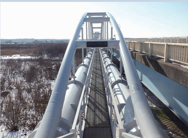
米代川水管橋
