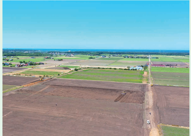
令和元年度面工事実施状況
