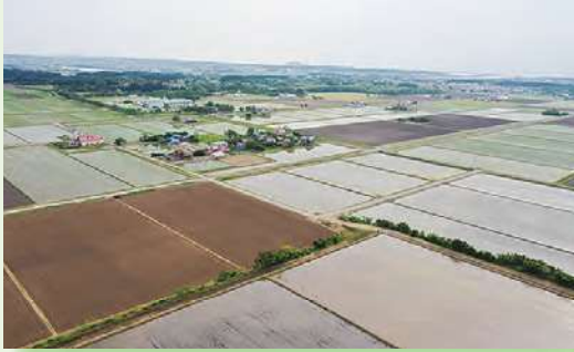
面工事完了状況
