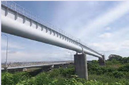
松山川水管橋
